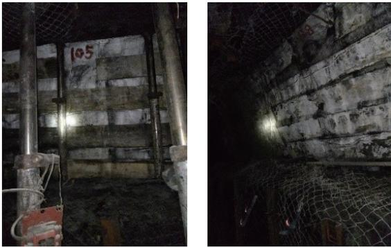
图 13 巷旁充填墙体井下施工
