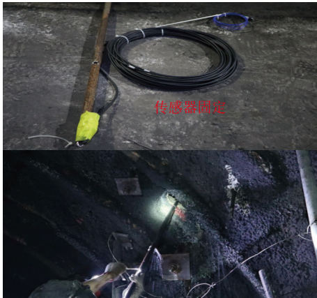
图11 应变传感光缆安装
