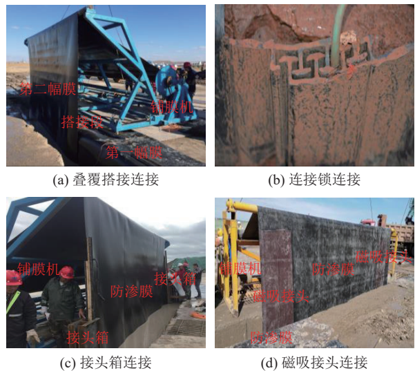
图 2 防渗膜接头连接工艺示意
