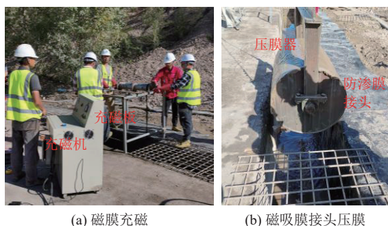
图6 磁吸防渗膜充磁及接头压膜
