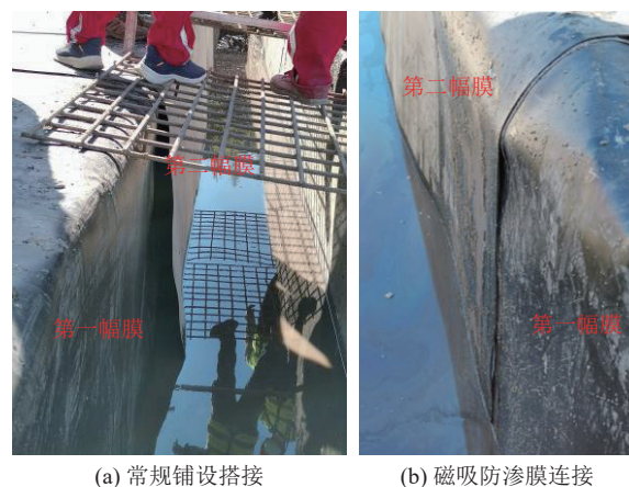
图7 柔性磁吸防渗膜与常规铺设效果对比
