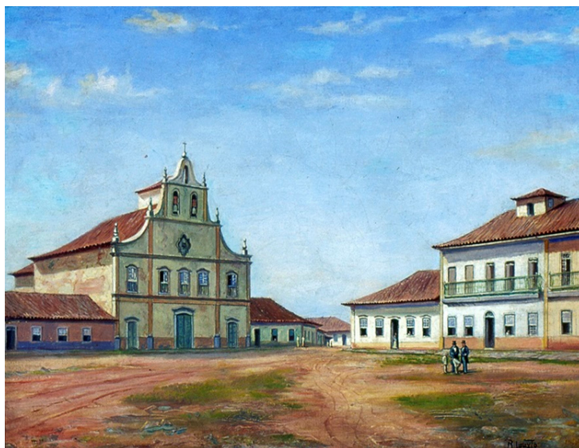
Figura 36 – Largo dos Remédios , 1862. Benedito Calixto, de 1918, baseada no registro fotográfico de Militão Augusto de Azevedo. Óleo sobre tela. A rua da Glória chegava a ele pela passagem estreita no centro da tela. Acervo Museu Paulista-USP.
