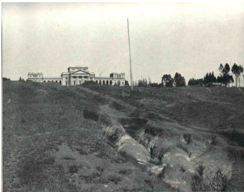
Figura 31 – Mastro e marco de pedra que assinalavam o local da independência, que foram desfeitos por ocasião da terraplenagem para a remodelação do terreno. Notar o museu ao fundo e a erosão do terreno em primeiro plano. Acervo Museu Paulista-USP.
