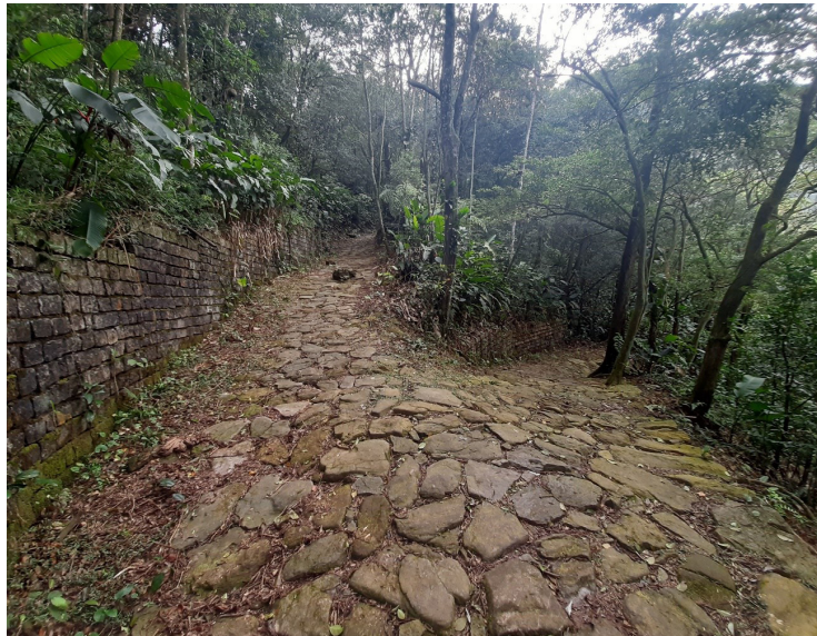
Figura 10 – Calçada do Lorena. Trecho logo abaixo do Padrão do Lorena. Notar o muro de arrimo à esquerda, que é de 1920, e a curva de quase 180°. Fotografia do autor.
