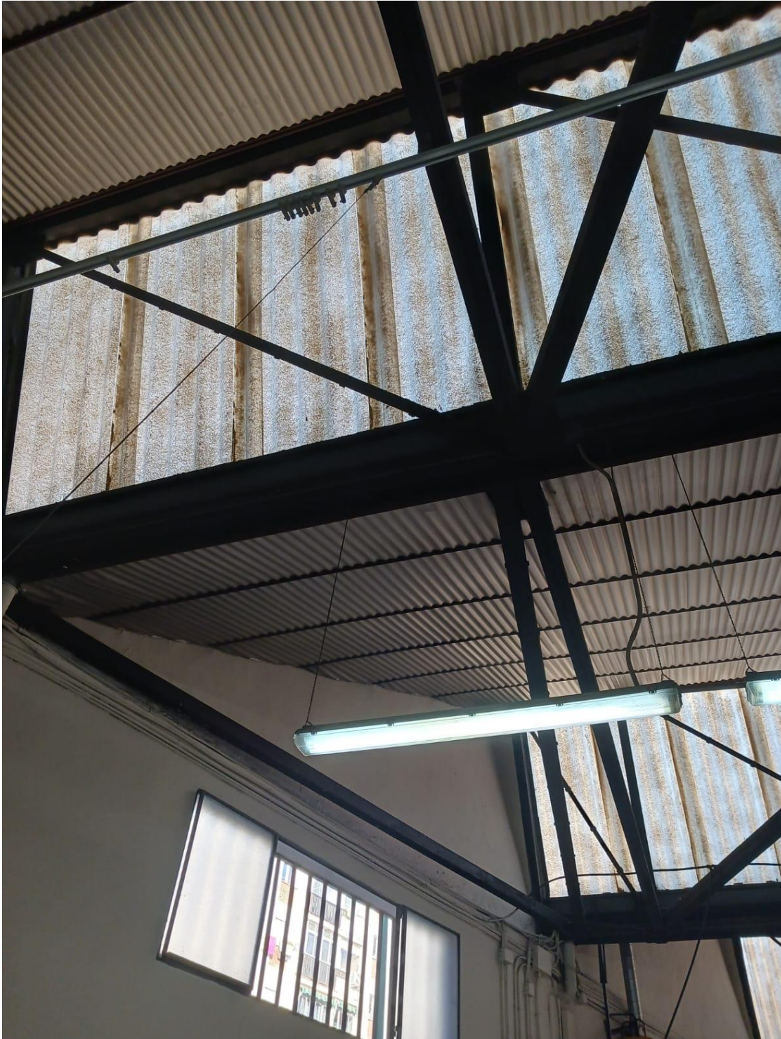
Figura 3. Paneles de fibrocemento en nave industrial en Málaga (Spain).
