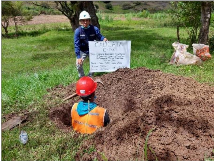
*Fig. 39: Excavación de calicata en la riera del cauce de la quebrada*
