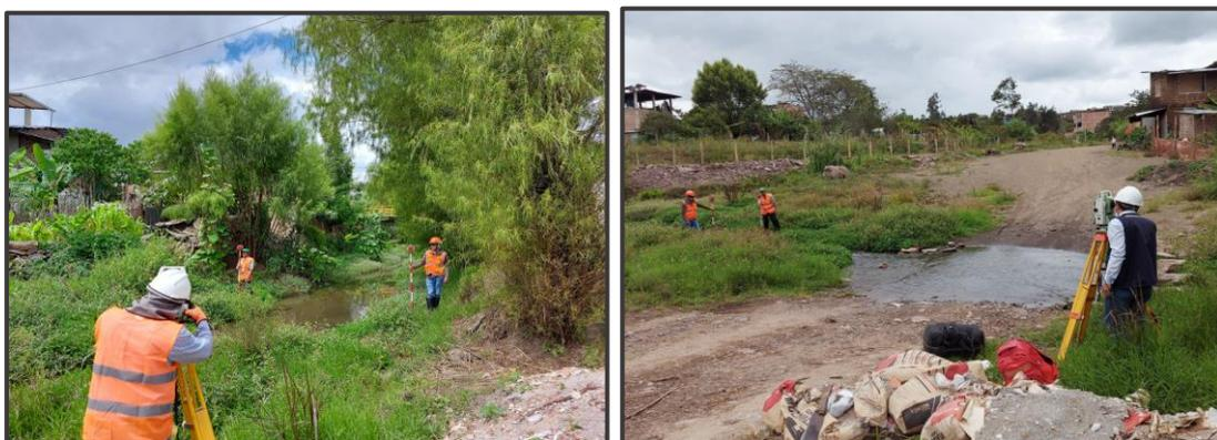
*Foto 13. Registro de puntos con prisma para tener un mejor detalle de la topografía de la zona de estudio.*
