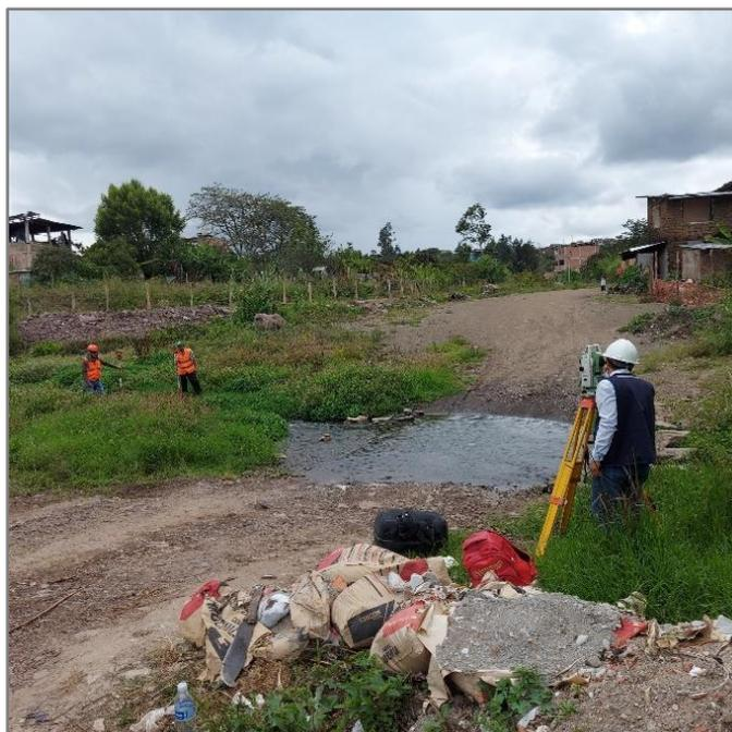
*Fig. 31: Levantamiento topográfico del tramo urbano del cauce de la quebrada El Pueblo*
