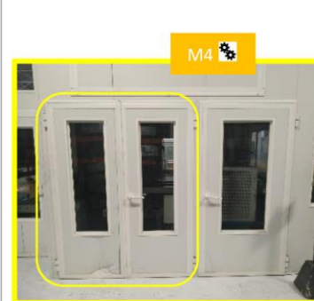
M4 – portal lateral de acesso a mesa do posicionador
