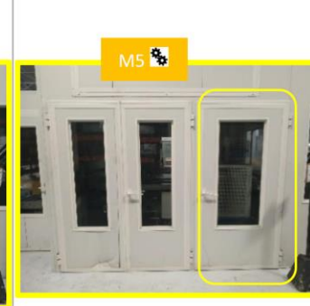
M5 – portal lateral de acesso a prensa
