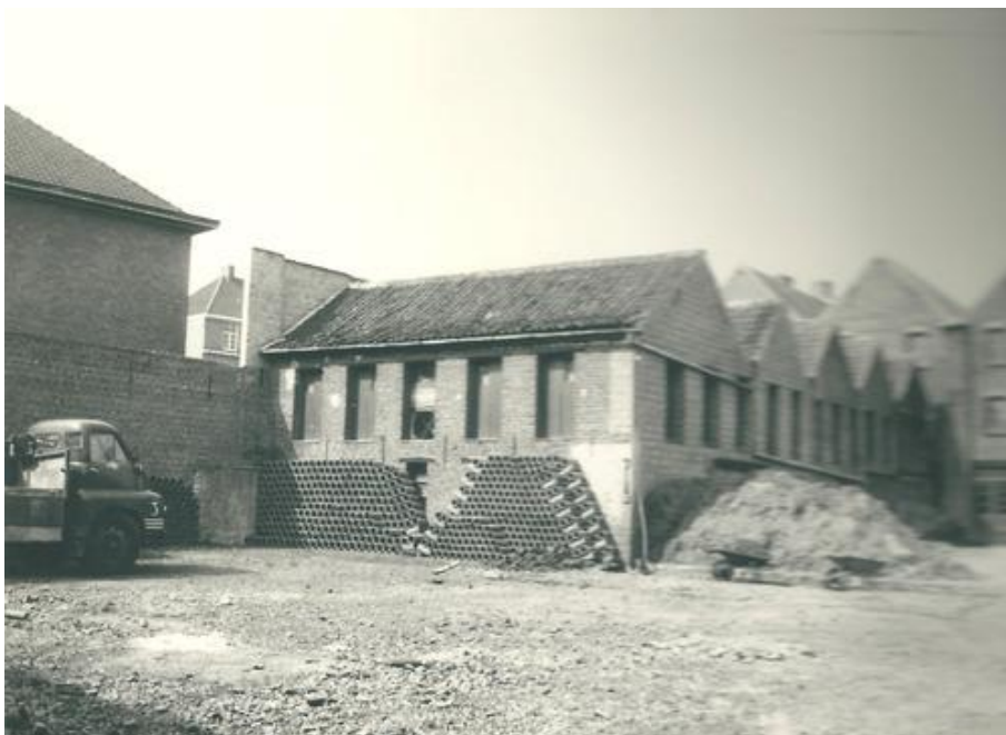
Figuur 17: De achterzijde van het perceel, zicht naar het westen op. We zien het fabricagegebouw, dat vijf delen omvat, tegen de scheidingsmuur met het college. Tegen de gevel liggen afgewerkte buizen klaar voor transport. Op de achtergrond, net tegen het fabricagegebouw, bevindt zich het gebouw met de ovens. Foto uit de periode 1960-1979. © Westhoek Verbeeldt; privé-collectie. De foto moet dateren van vóór 1977, aangezien het fabricagegebouw dat jaar instort.
