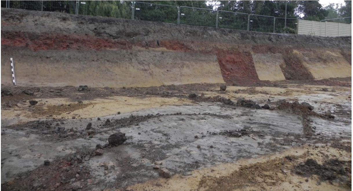
Figuur 2.11. Zicht op het noordelijke deel van de bouwput voorafgaand aan het archeologisch veldwerk. ©AGENTSCHAP OE
