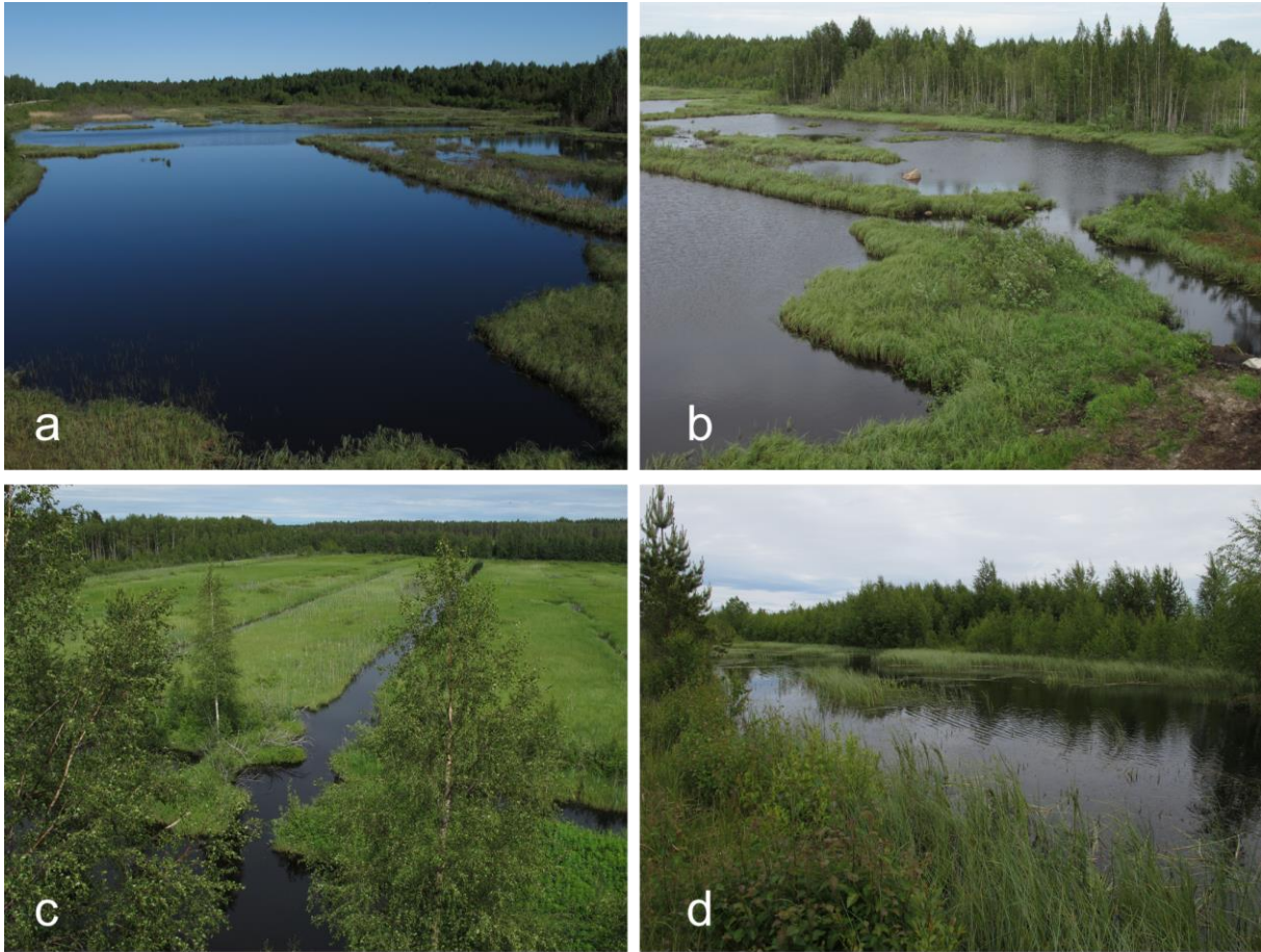
Kuva 25. Vuonna 2006 rakennettu kosteikko 12 (a) ja 15 (b) vuoden jälkeen (Kihniö, Aitoneva). Pinta-ala oli perustamishetkellä 9,3 ha, josta pysyvää avovesipintaa 1,5 ha. Kosteikon ympärille rakennettiin maavallit, jotta vesi pysyy alueella. Hoitotoimenpiteinä kohde on vaatinut mm. pajukon raivausta. Kuvassa c on soistunut, heinittynyt ja pensoittunut kosteikko, jossa vapaita vesialueita on suhteellisen vähän (kokonaispinta-ala noin 5 ha, turpeennoston päättymisestä alle 20 vuotta; Kankaanpää (Honkajoki), Satamakeidas). Kuvassa d on luontaisesti syntynyt kosteikko tuhkalannoitetulla saralla (Isojoki, Helmikäiskeidas). Kuvat: Lasse Aro.
