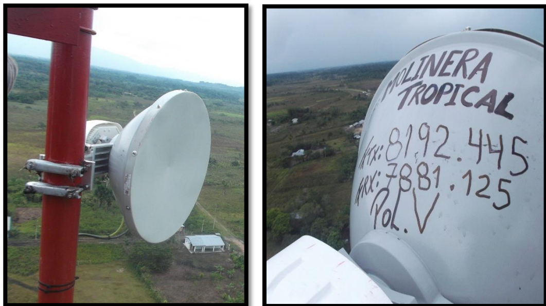
Figura 4.9- Antena y Odu Instalada en Torre (Apuntando a M.Tropical) Fuente: Elaboración Propia
