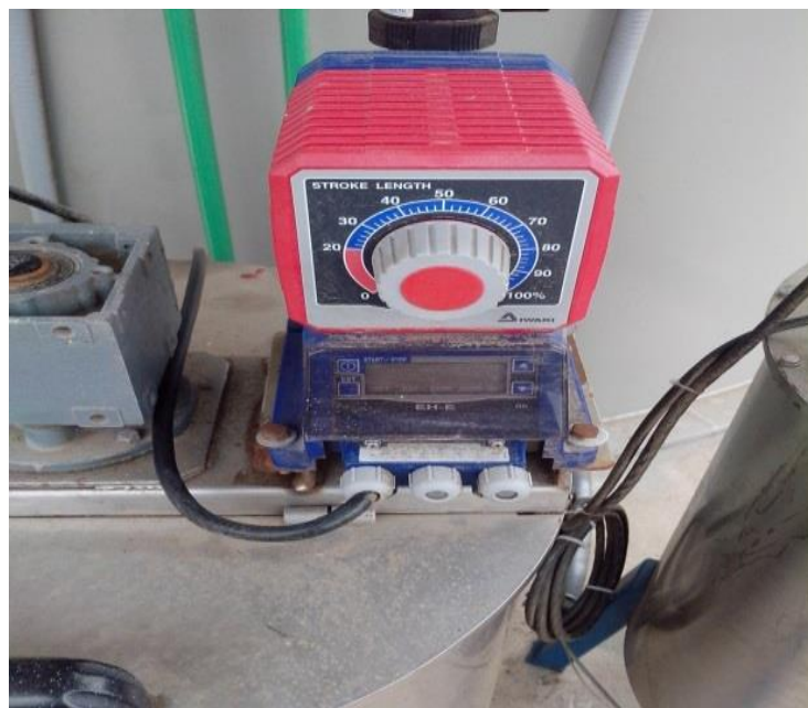
FIGURA 37 Bomba dosificadora electrónica marca iwaki
