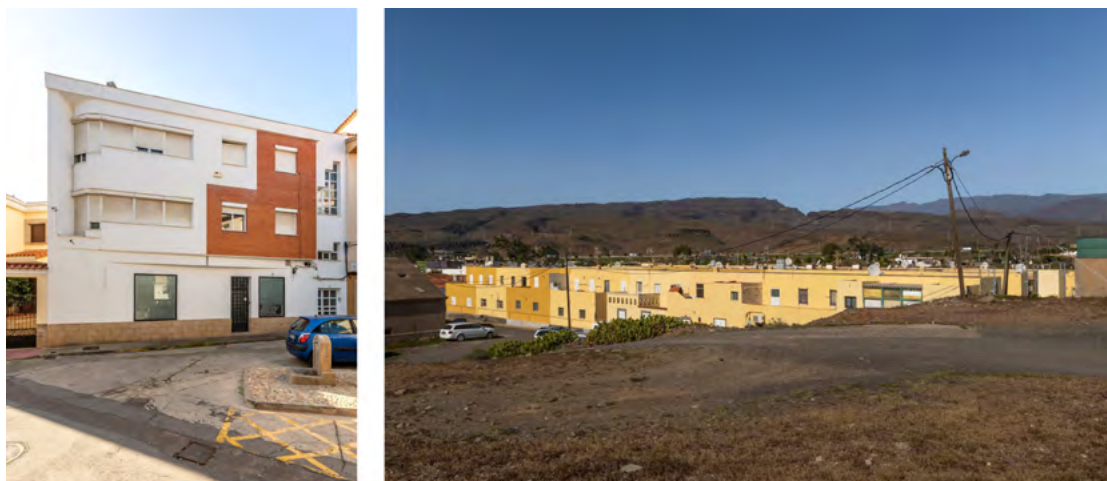
Imagen 3.—[Izquierda] Montserrat Zorraquino Ibeas, Viviendas y local familiar en Navalmoral de la Mata, 1985. Fotografía (estado actual) © Kelly Hurd. [Derecha] María Luisa González García, Conjunto de viviendas sociales en Juan Grande, 1983. Fotografía (estado actual) © María Rodríguez Cadenas.
