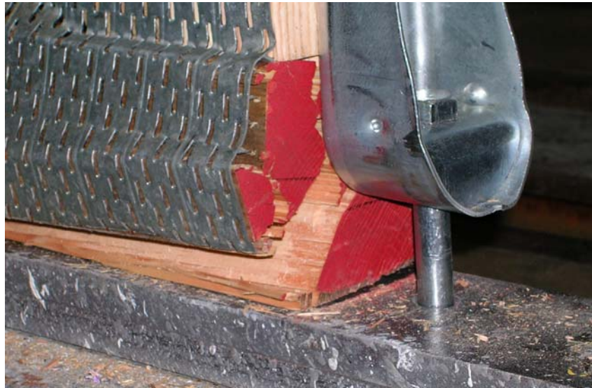
Fig. B23. Bottom-plate failure.
