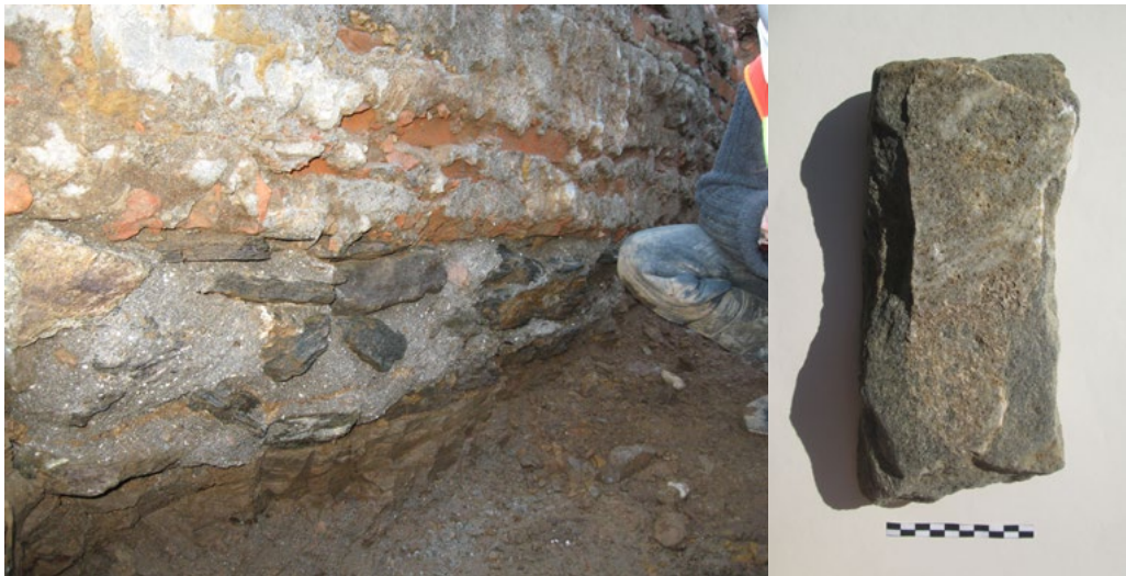
Figura 5. a: Basamento de arena, conchilla y piedra laja (esquisto) registrados en Casino de Valdivia. b: Laja de esquisto claramente canteada recuperada en la Plaza de la República.
