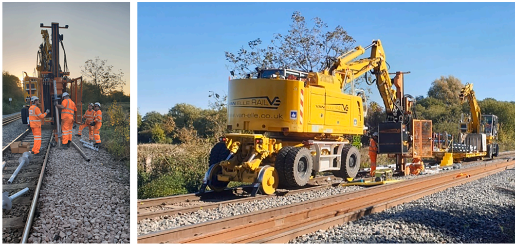
Fig 2. Trackbed stabilisation with micro-piling (Van Elle Ltd.).
