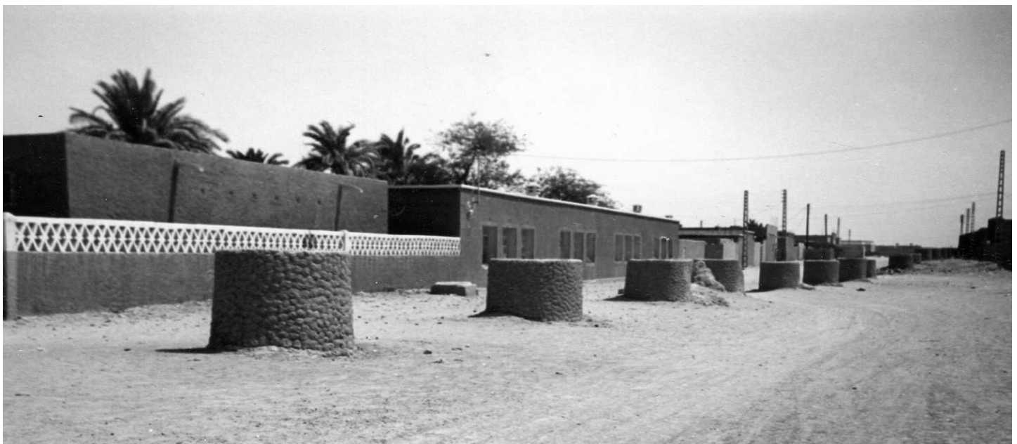
Figure 1. Alignement des puits d'une foggara à Timimoun (REMINI, 2007). Alignment of wells of a foggara in Timimoun (REMINI, 2007).
