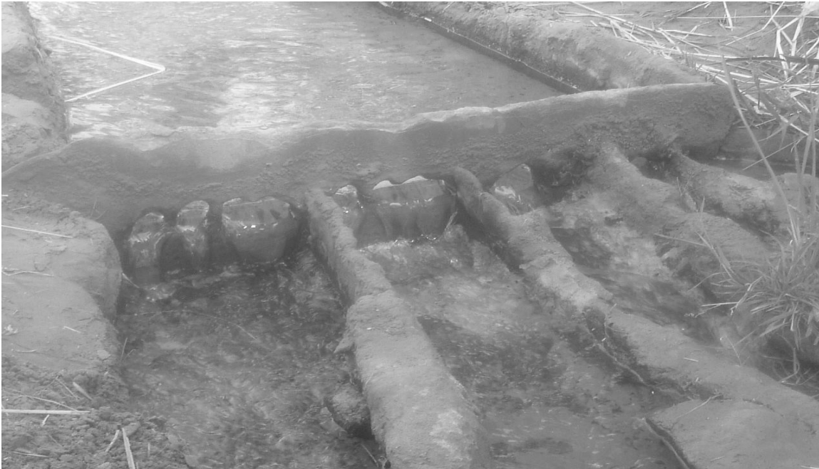
Figure 10. Kasria principale (partiteur) de la foggara Ouzziane (REMINE, 2008) Main Kasria (dispatcher) of the Ouzziane foggara (REMINE, 2008).
