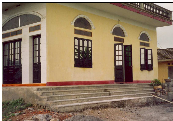
Figure 8. Exemple d'une nouvelle construction dans le quartier de Dong Thanh. Afin de lutter contre les inondations on surélève la maison d'environ un mètre. Photo : Éric Mottet, 2002.
