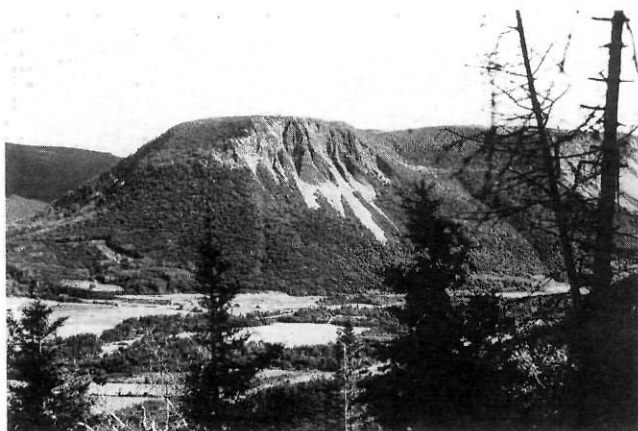
FIGURE 2. Vue générale de l'éboulis étudié. La paroi rocheuse (140 m de dénivelée) est disséquée par de profonds couloirs alimentant des langues de débris. Le site à l'étude est situé au bas de la grande langue de débris, qui fait 70 m de largeur et 330 m de longueur.
