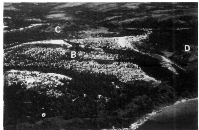
FIGURE 4. Vue aérienne oblique (vers le sud) des glissements dans le secteur amont.
