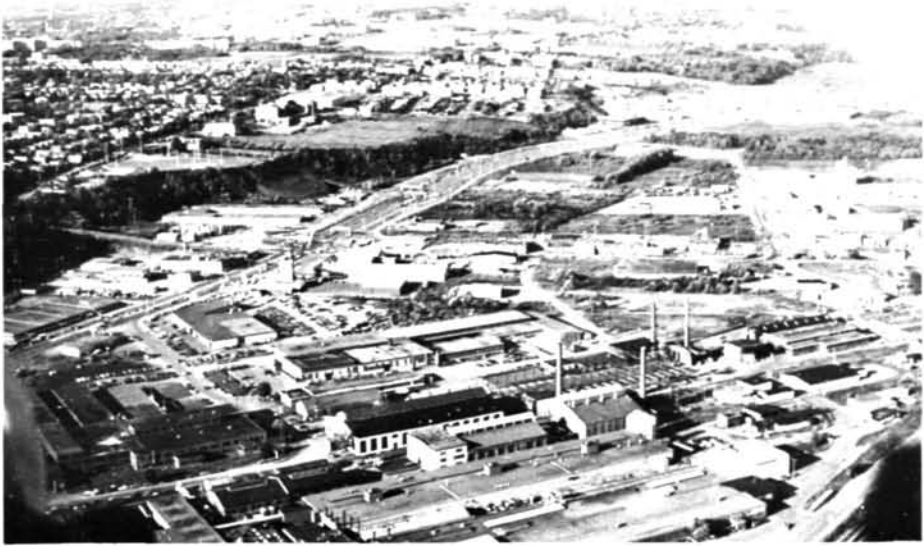
Photo 1 Le parc industriel de Saint-Malo (premier plan) et son prolongement vers l'ouest : parcs industriels de Duberger et Jean-Talon (dépression Cap-Rouge - Limoilou) ; — au premier plan deux établissements importants : ● Cartonniers Standard (usine de boîte en carton, plus de 200 emplois) ; ● Good Year (usine de pièces de caoutchouc pour l'industrie automobile, 300 emplois) ; — au second plan, la banlieue de Sainte-Foy.
