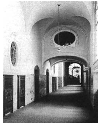
Bild 3.56: Das Neue Kriminalgericht Berlin-Moabit, „Flur im Erdgeschoß des Saalbaues mit brückenartigem Einbau für die Gefangenenzuführung“, erbaut 1906-1908, Architekten Carl Vohl und Rudolf Mönnich, Foto: 1908
