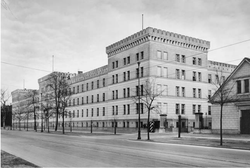
Bild 3.4: Garde-Husaren-Kaserne in Potsdam erbaut 1841, Architekten: Johann Georg Hampel, Karl Friedrich Schinkel, Foto um 1890 © Bildarchiv Foto Marburg
