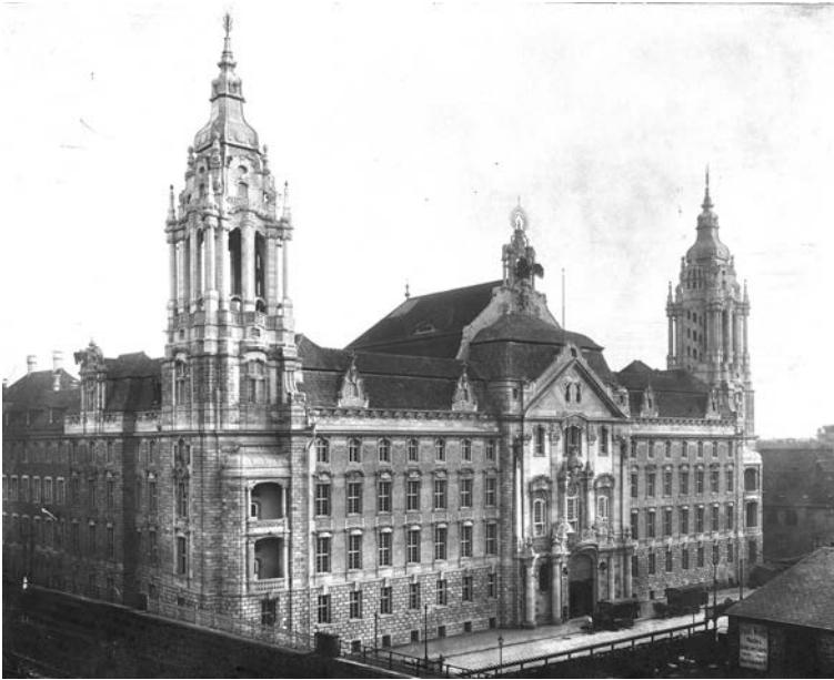
Bild 3.62: Amtsgericht Mitte, Blick von der Stadtbahn, erbaut 1894-1904, Architekten Rudolf Mönnich, Paul Thoemer, Otto Schmalz, Foto: 1905
