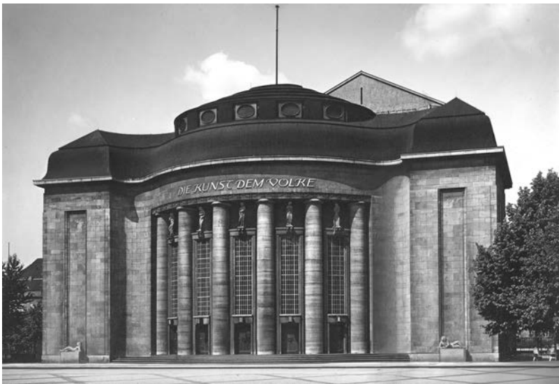
Bild 4.21: Volksbühne am Bülowplatz, erbaut 1913-1914, Architekt: Oskar Kaufmann, Foto: um 1918
