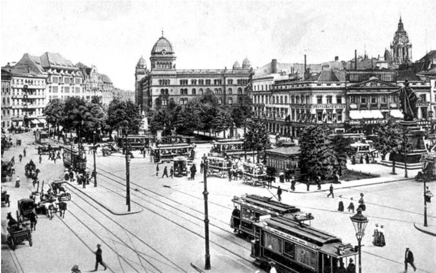
Bild 3.51: Polizeipräsidium am Alexanderplatz, erbaut 1886-90, Blick vom Alexanderplatz, rechts der Turm des Amtsgerichts Mitte, Architekt Hermann Blankenstein, Postkarte um 1900
