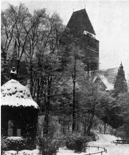
Bild 4.14: Märkisches Museum, erbaut 1899-1908, Ansicht von Südosten, Architekt Ludwig Hoffmann, Foto 1908/09
