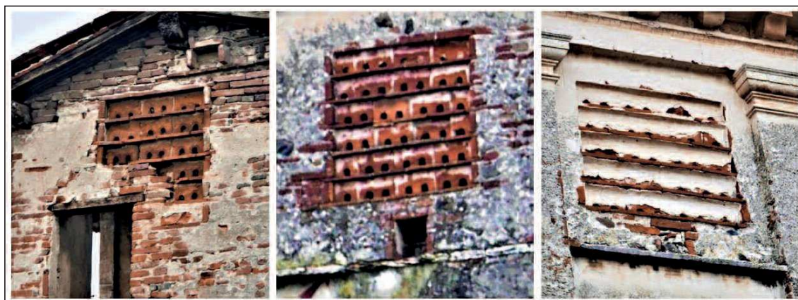
Fig. 13 — Da sinistra a destra: particolari delle aperture in laterizio delle colombare di Malo (Via Leonardo Da vinci), di Villa Randi Guglielmini e di “Ca’ Ostile” (in cui sono ben visibili sotto l’intonaco) a Breganze; 2 gennaio 2023, foto Paolo Fontana.
