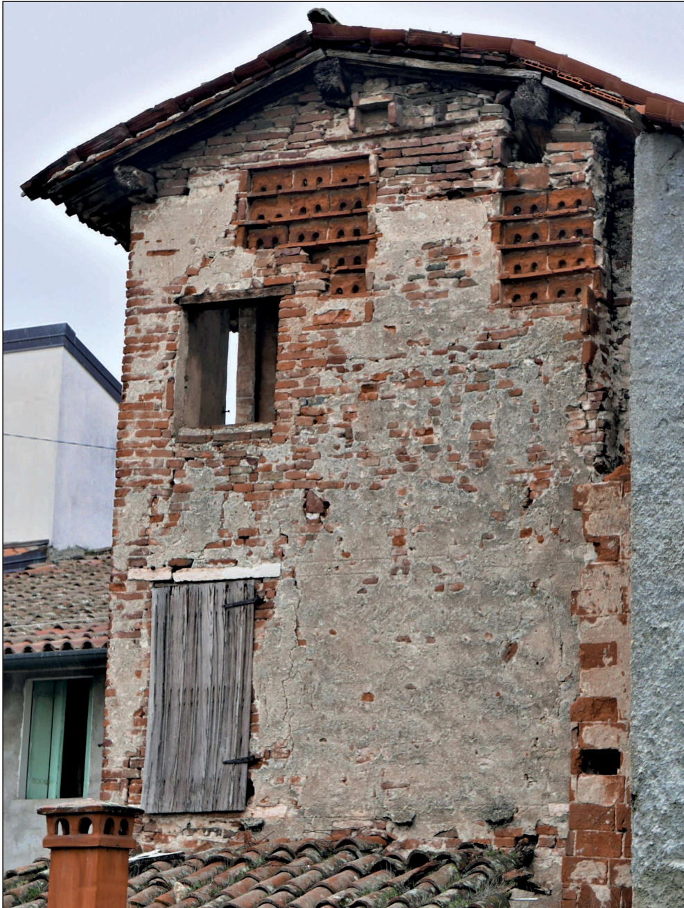
Fig. 9 — Colombara collocato al piano più alto di un edificio rurale nei pressi del centro di Malo (Vicenza) in via Leonardo Da Vinci, lungo la SP 46; 2 gennaio 2023, foto Paolo Fontana.
