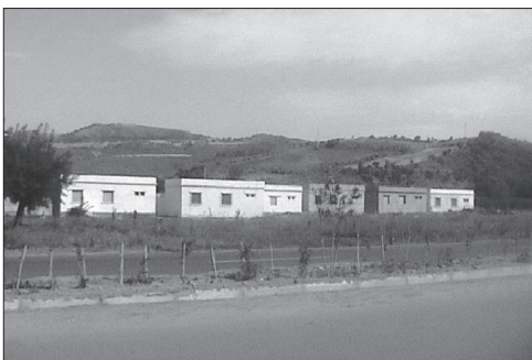
Ensemble d'habitat rural sur une Exploitation agricole collective (EAC) (les huit exploitants de l'EAC ont bénéficié de logement rural)
