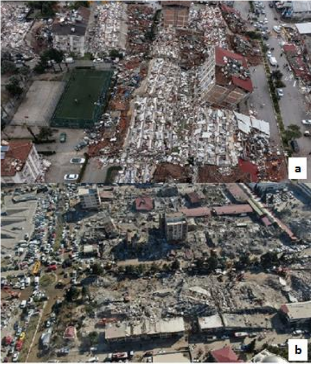
Şekil 2. Depremlerin a) Hatay ve b) Gaziantep illerinde meydana getirmiş olduğu yıkım (İnt Kyn. 6).
