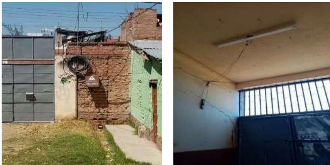
*Figura 4. Conexiones eléctricas en mal estado/inadecuadas*
