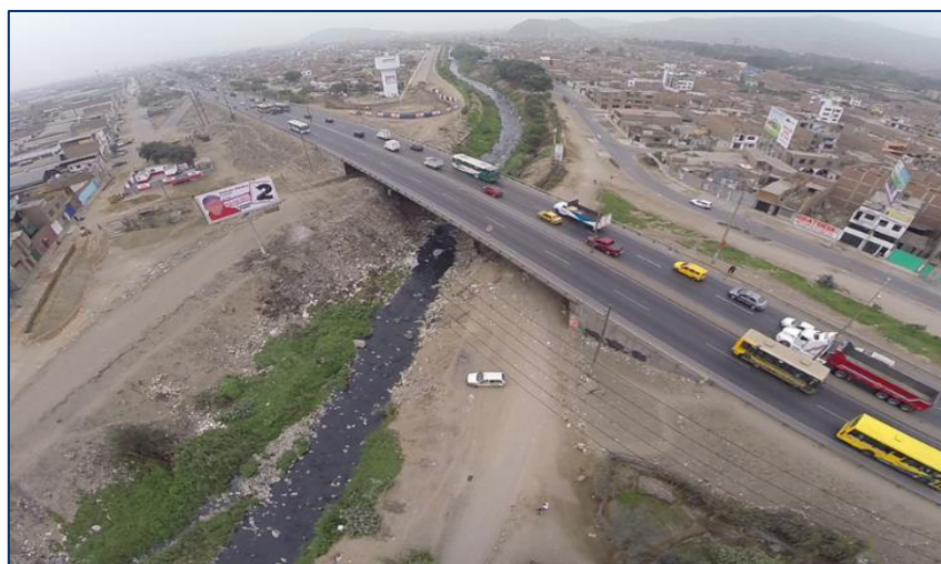
Figura N° 32. Puente Chillón antes de ser intervenido por la concesionaria Rutas de Lima (CRL). Fuente: Concesionaria Rutas de Lima (CRL), 2022.
