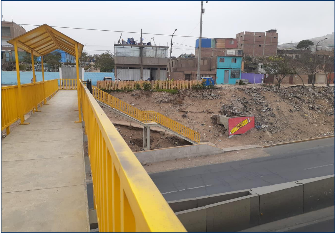
Figura N° 80. Estado del paradero Concordia.
