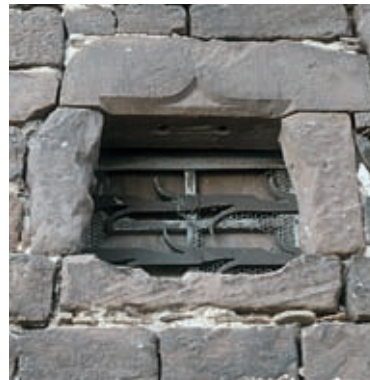
Fig. 214. Finestra amb arc conopial que s'obre a la façana septentrional del cos A del castell. Foto: J. Miquel i Solé, 1990. Arxiu fotogràfic SPAL.
