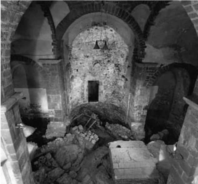
Fig. 227. Excavació de l'església. Vista general dels murs corresponents als àmbits I, II, III, V, VII i al passadís VI de la vil·la romana, descoberts a l'absis, absidiola sud i transsepte. Foto: J. Miquel i Solé, 1990. Fons documental SPAL.
