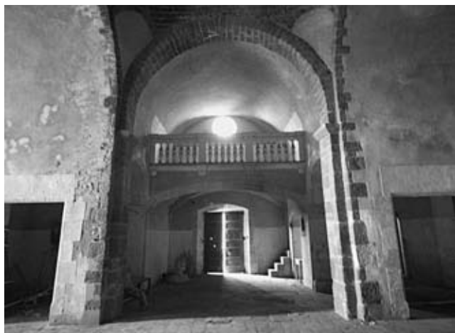
Fig. 203. Vista des de llevant de l'interior de l'església de Santa Maria abans de l'excavació. En primer terme la nau central amb les capelles laterals i el cor al fons. Foto: J. Francés, 1988. Fons documental SPAL.
