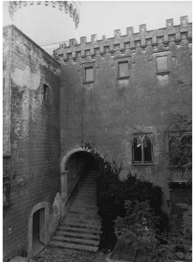
Fig. 217. Vista de l'angle sud-oest del pati P1 del castell. A l'esquerra, la porta que dona a l'àmbit CA2, acabada en arc carpanell, del segle XVIII, i al seu costat les traces de l'antiga porta del segle XVI. Al centre, l'escala i arc de mig punt que donen accés a la planta noble. A la part alta, dues finestres del segle XVI i dues d'imitades el 1897, i a sota, finestra coronella del mateix any encaixada en una altra del segle XVI. A la dreta, tribuna feta durant la restauració de 1897, abans de ser desmuntada després del seu enfonsament parcial, l'any 1991. Foto: J. Miquel i Solé, 1990. Fons documental SPAL.
