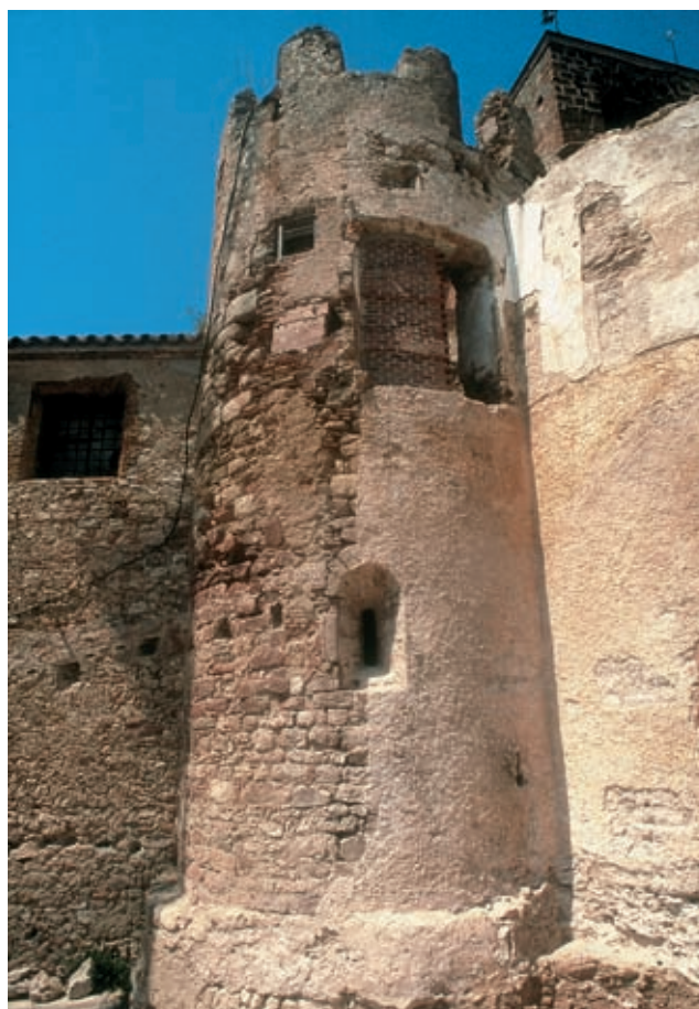
Fig. 264. Absidiola sud de l'església amb la capella de la Mare de Déu de la Salut adossada al mur meridional, un cop desmuntada la sagristia. Cal observar el recrescut de l'absidiola, fet al segle XIV, coronat de merlets. També, a sota, a la dreta, es veu una tronera per una petita peça d'artilleria. Foto: M. Baldomà, 1992. Arxiu fotogràfic SPAL.
