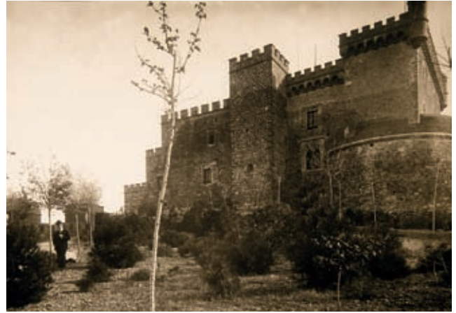
Fig. 212. Vista general de la façana septentrional del conjunt, després de la primera restauració. 1898. Arxiu fotogràfic SPAL.
