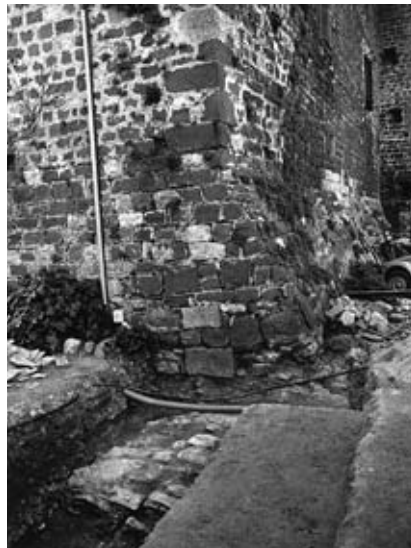
Fig. 248. Sondeig VII, en la ronda Ro2, al costat de la torre T3. Ruïnes de la porta de la fortificació del segle XVI, oberta al pany de tramuntana. Foto: A. Caixal, 1990. Fons documental SPAL.
