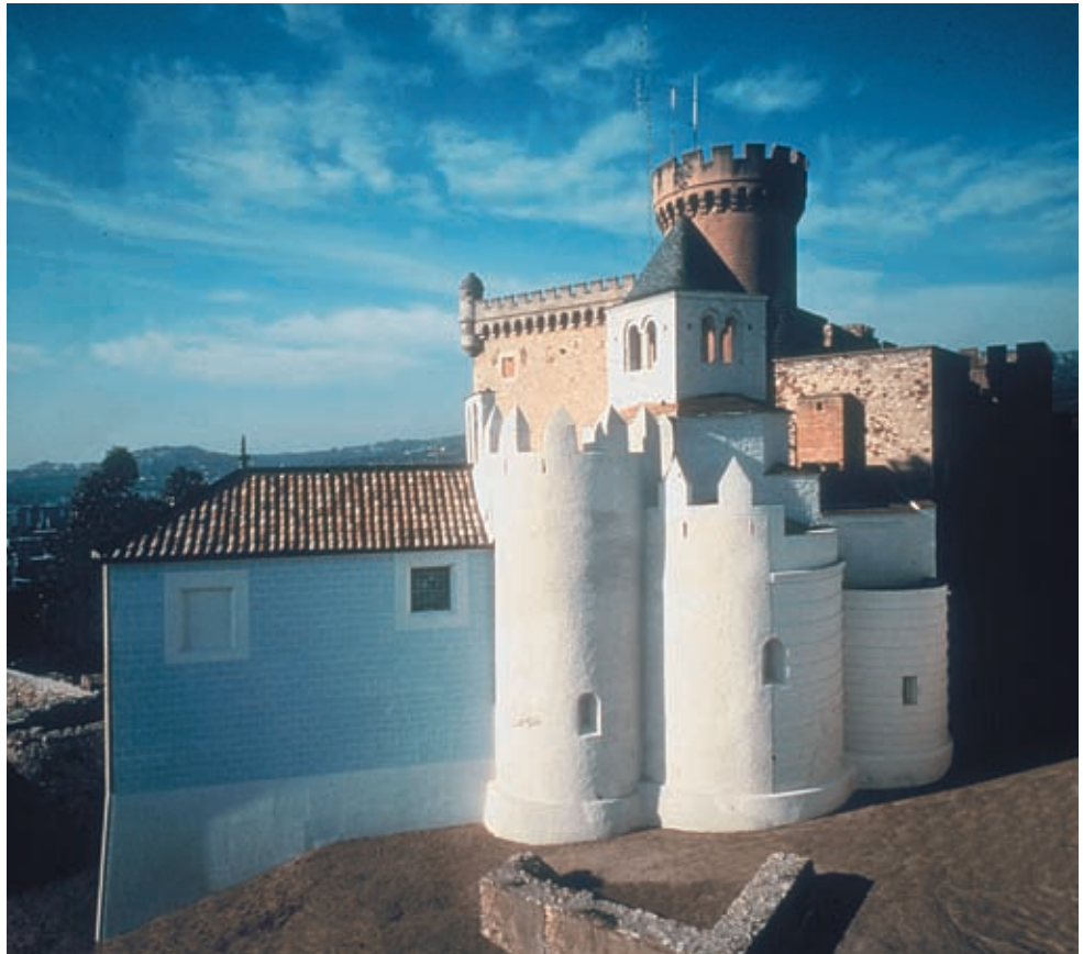
Fig. 200. Vista general de l'església des de llevant després de les obres de restauració, amb l'absis posat al descobert un cop desmuntada la sagristia. Foto: M. Baldomà, 1995. Arxiu fotogràfic SPAL.
