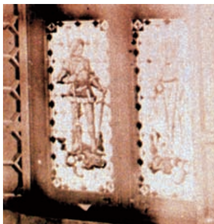
Fig. 383. Segona finestra del saló. Foto: M. Cosmèn, 1898, Ajuntament de Castelldefels.
