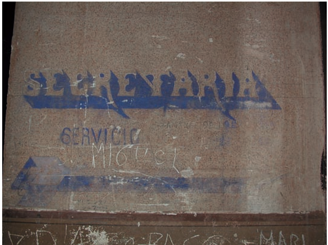
Fig. 282. Rètol que indica la situació de la secretaria del comandant de la presó de les Brigades Internacionals, a la planta primera del castell. Foto: David Galí, 2002. Arxiu fotogràfic SPAL.
