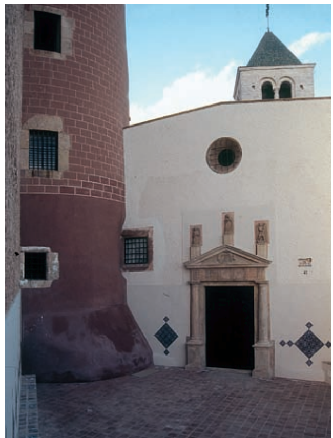
Fig. 202. Façana de ponent de l'església de Santa Maria, pati P3 i torre T5 un cop finalitzades les obres de restauració. Foto: M. Baldomà, 1995. Fons documental SPAL.
