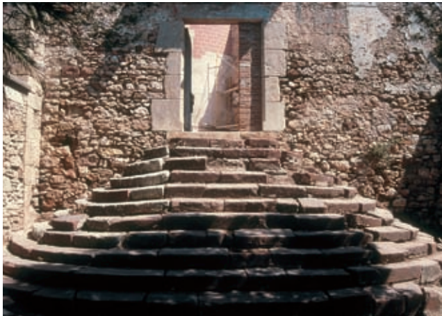
Fig. 251. Sondeig XI. Graonada que comunica la ronda Ro5 amb el pati P3, abans de l'excavació. Foto: A. López Mullor, 1995. Arxiu fotogràfic SPAL.
