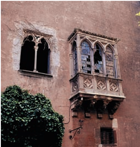
Fig. 216. Tribuna amb arcs ogivals (parcialment caiguda el 1991 i desmuntada tot seguit) i finestra coronella amb traceria que s'obre al pati P1 del cos A del castell, abans de les obres de restauració. Foto: J. Miquel i Solé, 1990. Arxiu fotogràfic SPAL.
