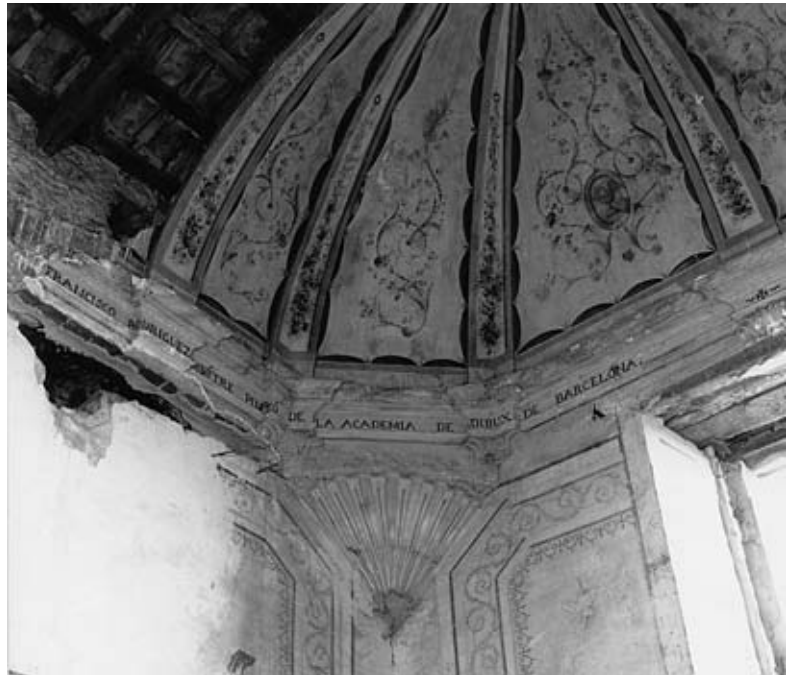
Fig. 208. Detall de la decoració mural de l'interior de la capella de la Mare de Déu de la Salut, abans de la restauració, amb part de la inscripció que ens ha pervingut, on figura el nom de l'autor de les pintures neoclàssiques: «FRANCISCO RODRIGUEZ MESTRE PINTÓ DE LA ACADEMIA DE DIBUX DE BARCELONA». Foto: J. Miquel i Solé, 1990. Fons documental SPAL.
