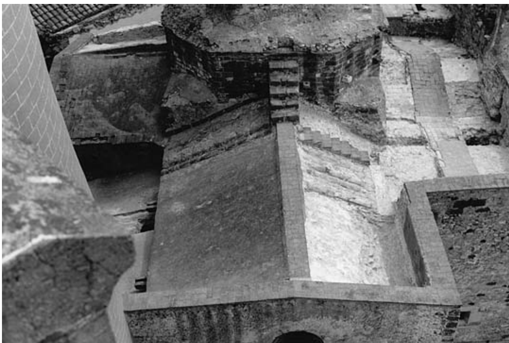
Fig. 234. Excavació de la coberta de la nau central, del braç sud del transepte i de la capella del Roser. A la nau hi ha la coberta del 1910, per sobre de la teulada anterior. Al transepte i la capella s'observa el testimoni de la coberta de rajols del segle XVI, fundacional en la capella i que en el transepte recolza sobre la volta romànica, ja que encara no s'hi han descobert els vestigis de les lloses que la van precedir, situats en els laterals, a més fondària. Foto: A. Rius, 1991. Fons documental SPAL.
