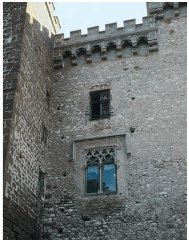
Fig. 215. Finestral amb traceria, col·locada el 1897, i finestra original, del segle XVIII, més senzilla, que s'obren a la façana septentrional del cos B del castell. Foto: J. Miquel i Solé, 1990. Arxiu fotogràfic SPAL.
