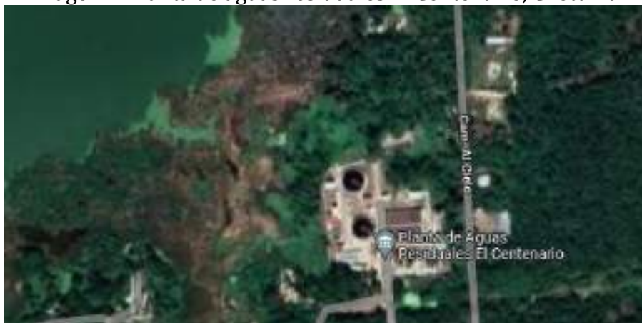
Imagen 1. Planta de aguas residuales El Centenario, Chetumal
