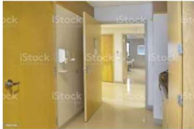
Gambar 3.8 : Contoh pintu ruang perawatan di rumah sakit
