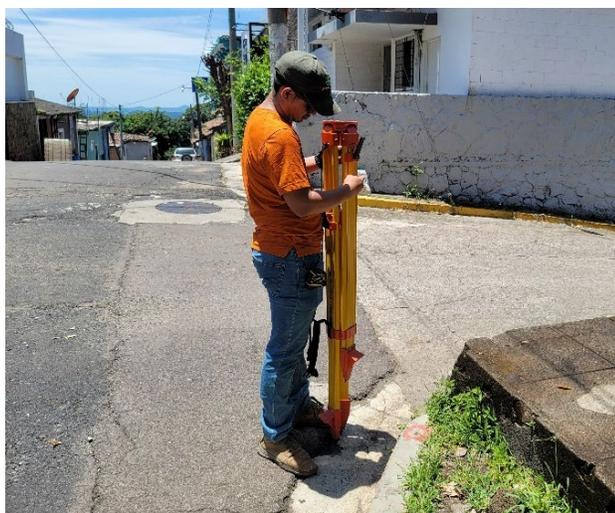
*Imagen 3- 6 Colocación de trípode sobre vértice geodésico.*
