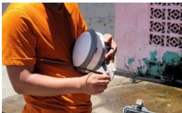
*Imagen 3- 10 Fijando antena en soporte.*
