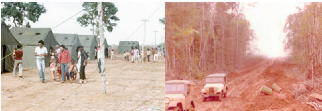
Figura 4: Acampamento fornecido pelo INCRA às famílias de posseiros vindos do Rio Grande do Sul e abertura de estradas em Lucas do Rio Verde, no ano de 1981 Fonte: Acervo Prefeitura Municipal, cedido em 2009.
