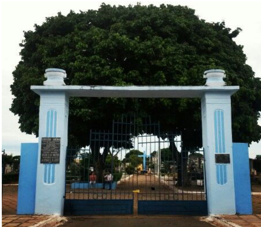
Figura 1: Fachada do Cemitério Santana, 1940.
