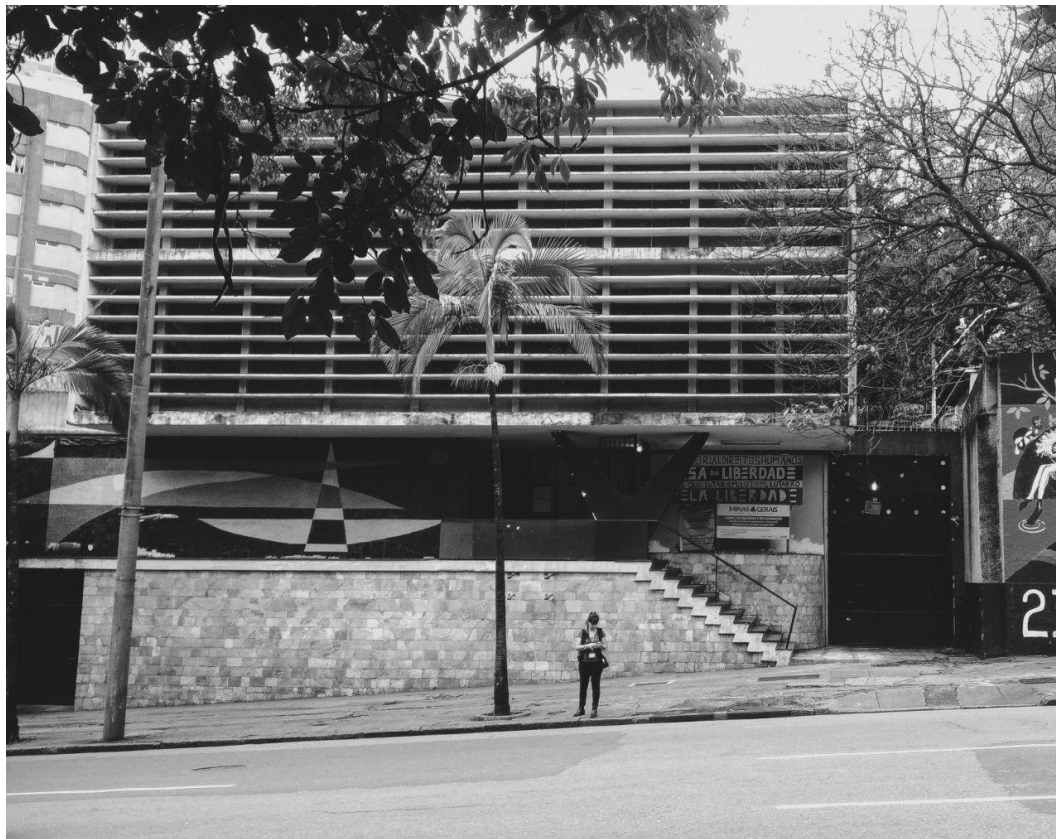
Figura 1: Fachada do prédio principal das instalações do antigo DOPS/MG.
