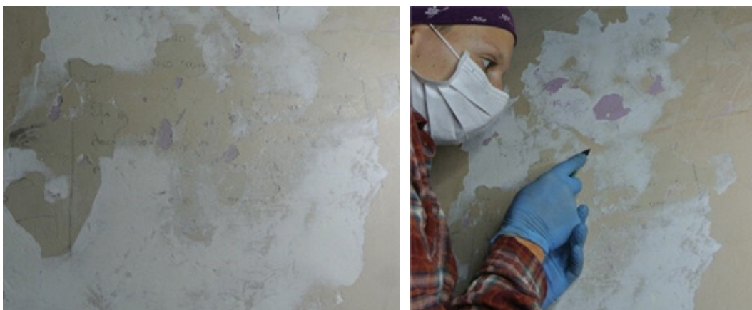
Figura 13: Foto do trecho da parede de uma das celas que foi escavado e foto do trabalho de escavação.
