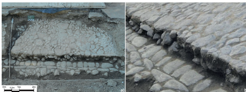
Figura 4: a) Porção com sobreposição entre os pavimentos tipo Pé de Moleque [01] e [02]; b) Detalhamento da área de sobreposição, podendo-se ver o uso de aterro e blocos de rocha para nivelar esse calçamento na área sobre a canaleta central do anterior.
