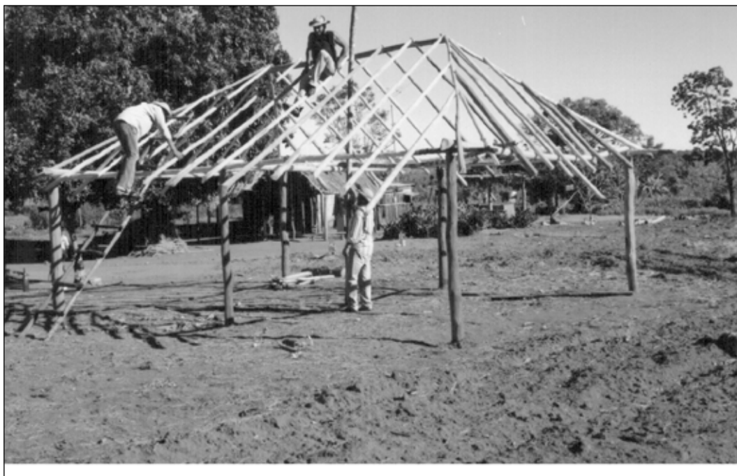
Figura 9: Construção de casa
