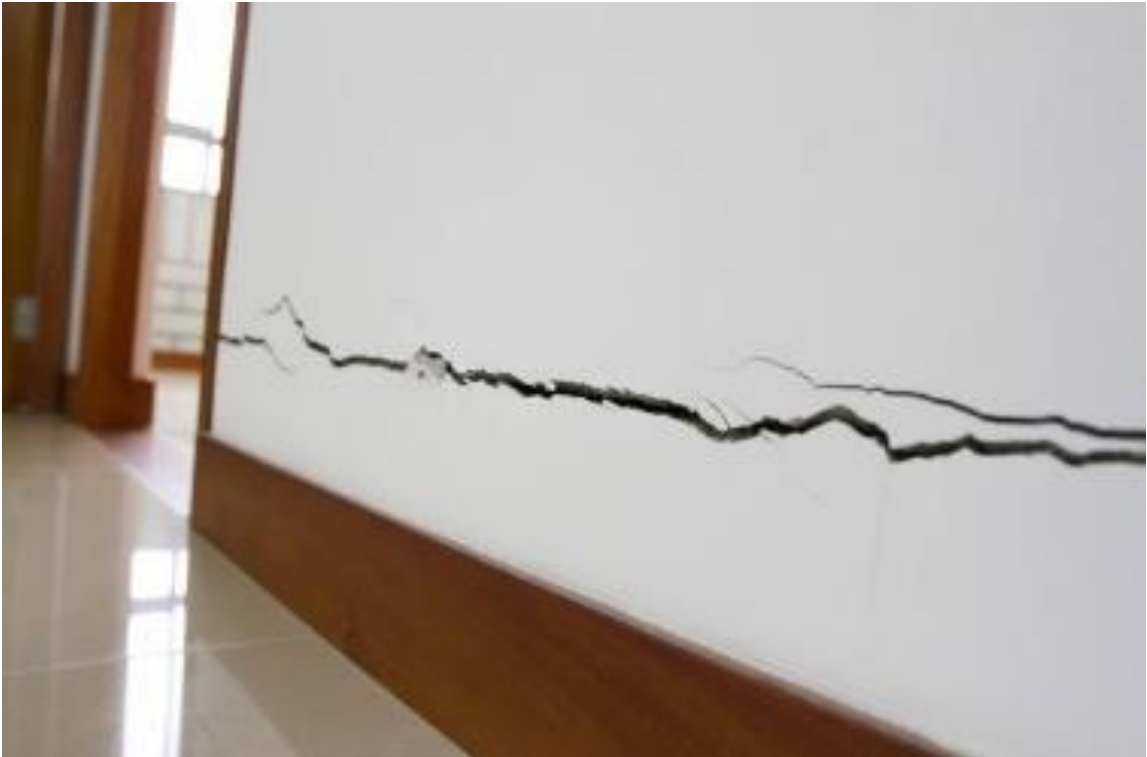
Gráfica 6 Fotografía de las deflexiones de las placas del edificio Space
