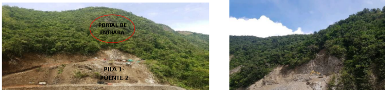
Figura 7. Localización Portal entrada túnel de fueimia
