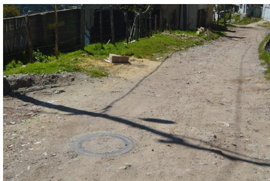
Pozo de inspección sobre vía vehicular
