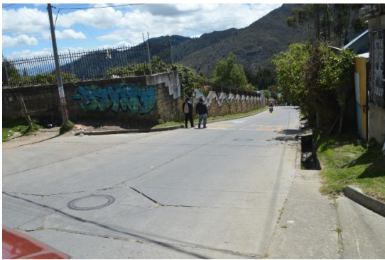
Pozo de inspección sobre vía vehicular
