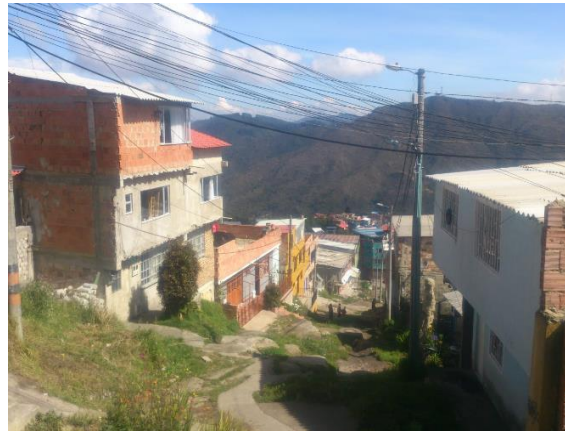
Calle con red de alcantarillado
