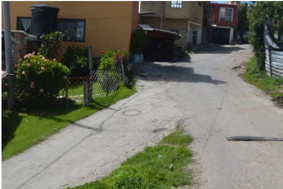
Pozo de inspección sobre vía vehicular
