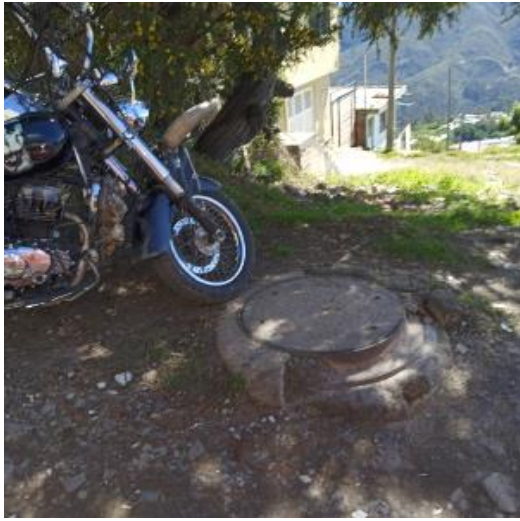
Pozo de inspección lateral a la vía vehicular
