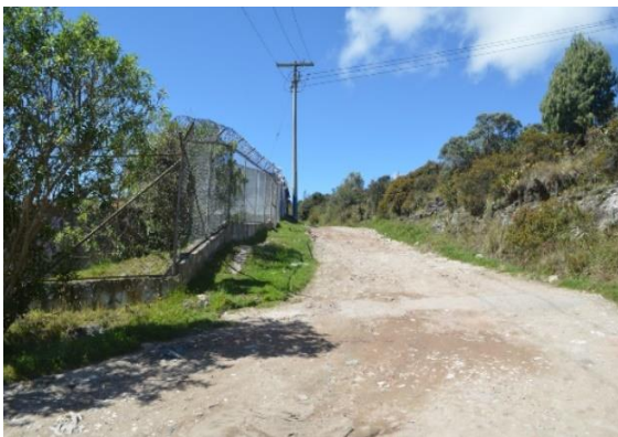
Entrada al Barrio La Esperanza y comienzo de una de las redes de alcantarillado
