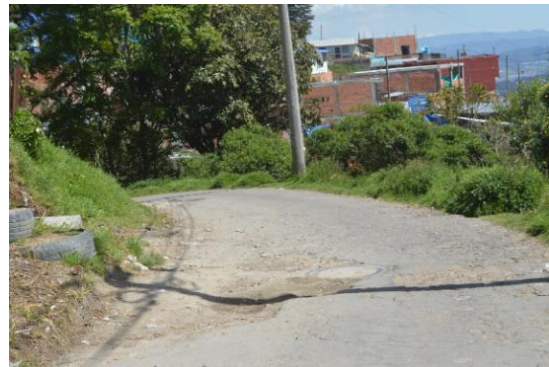
Pozo de inspección sobre vía vehicular
