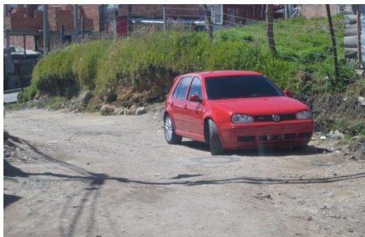
Pozo de inspección lateral a la vía vehicular
