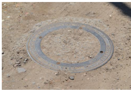
Pozo de inspección
