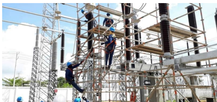
Imagen 4. Actividades de Montaje en Subestación eléctrica.
