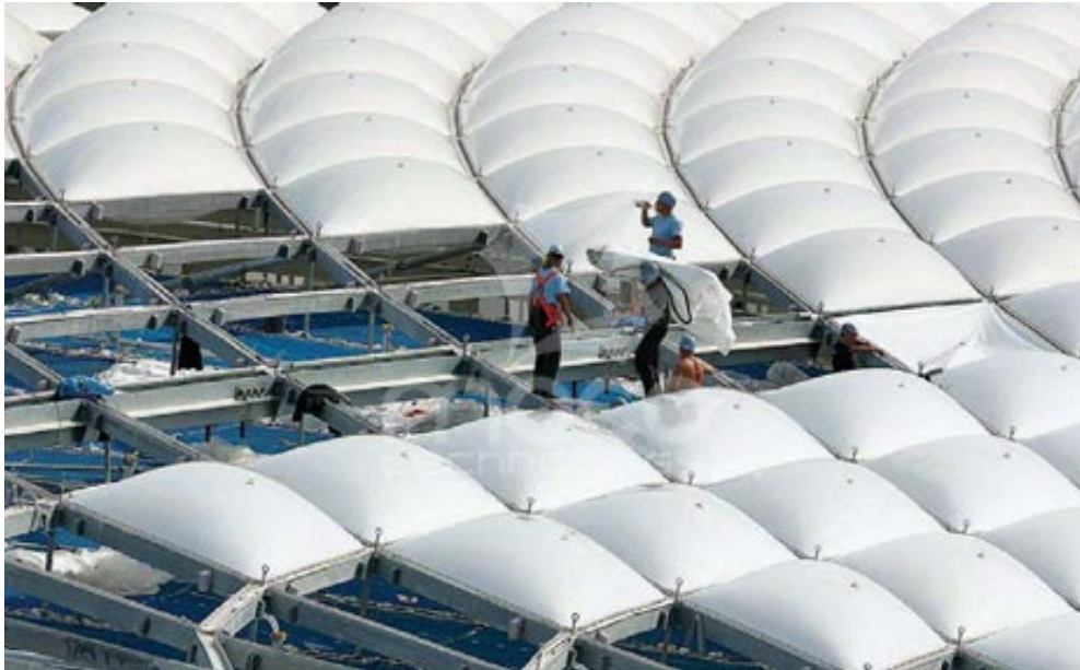
Figura 37. Instalación paneles EFTE en cubierta estadio Allianz Riviera
