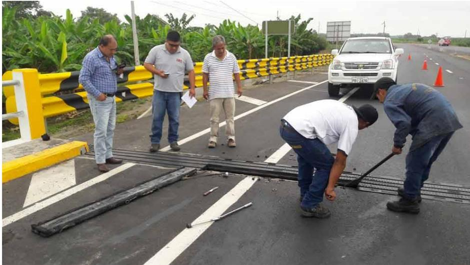
Figura 12, Mantenimiento de juntas
