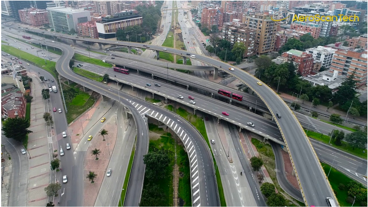
Figura 10. Infraestructura vial (puente de la calle 92 con autopista norte, Bogotá)
