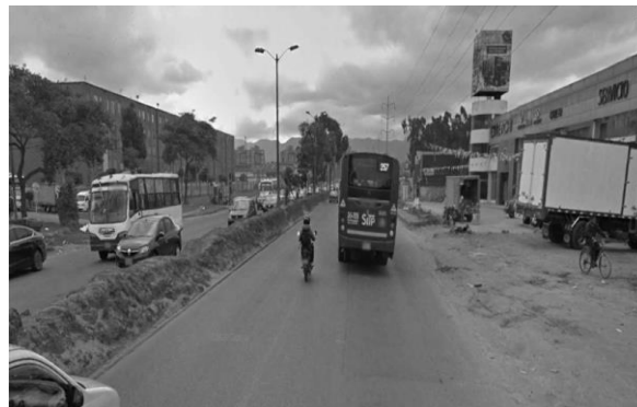
Figura 8. Estado actual del Barrio Sabana Grande.
