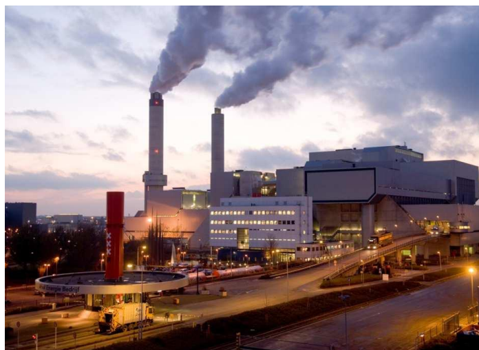
Figura 9. Instalaciones de recuperación de energía
