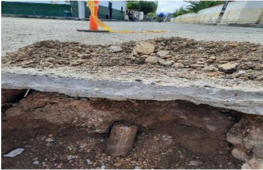
Ilustración 2 Características de la estructura del pavimento actual
