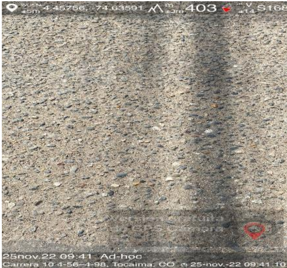
Ilustración 14 Pulimiento del agregado Fuente: Elaboración propia
