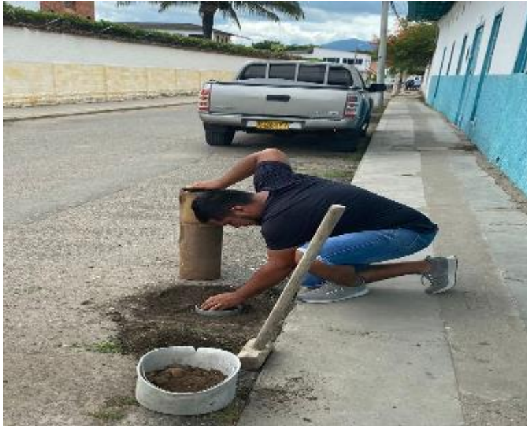
Ilustración 19 Hincada de cilindro (Apique N°1) fuente: Autores
