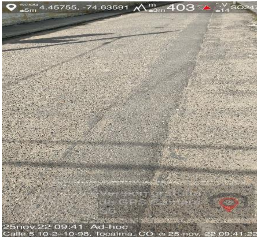
Ilustración 15 Parche en el corredor vial fuente: elaboración propia
