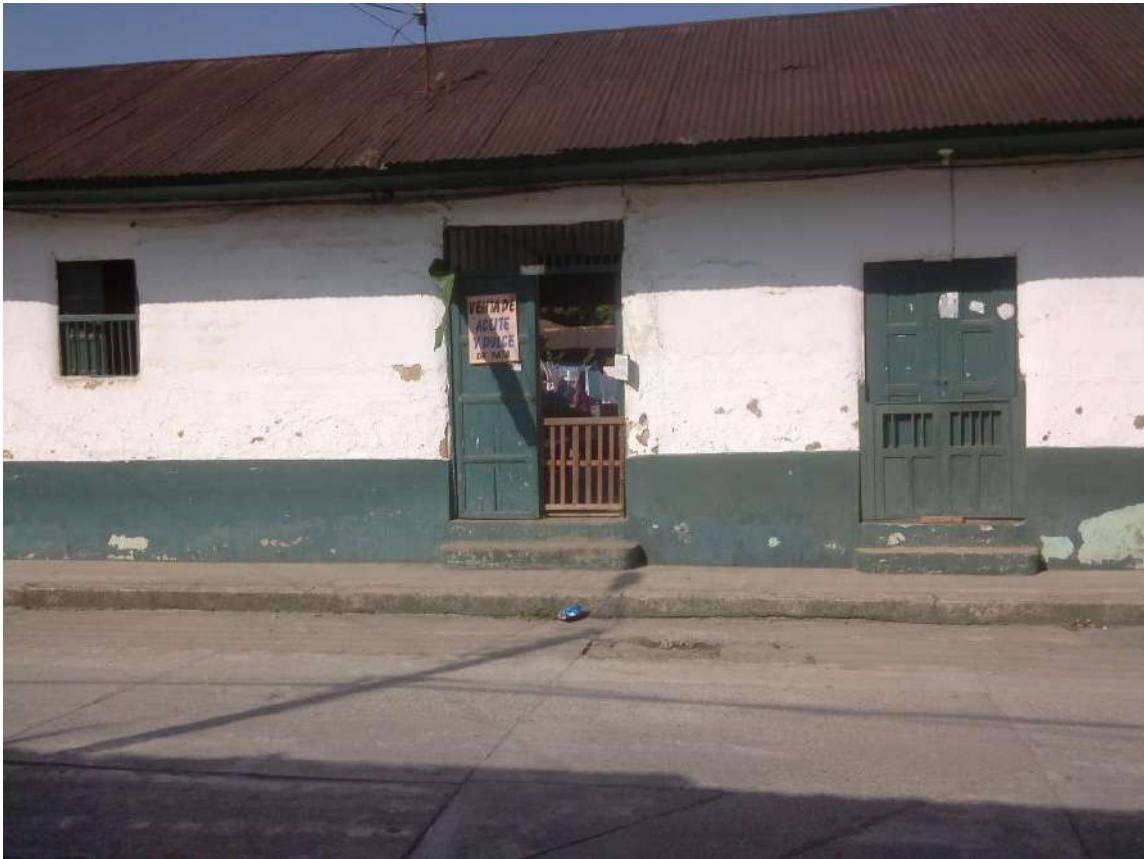
IMAGEN DE REFERENCIA TOMADA POR EL AUTOR. SAN MARTÍN, META. CASA EN BAHAREQUE.
