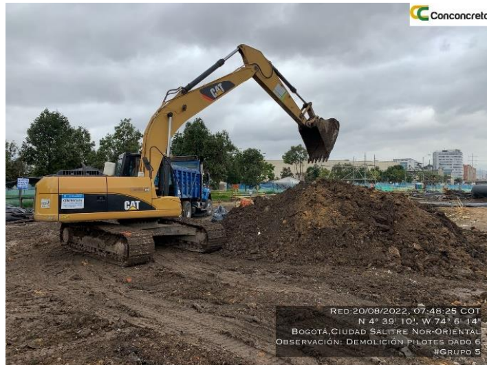
Imagen 8. Excavación mecánica mediante retroexcavadora. Fuente: CONSTRUCTORA CONCRETOS S.A.
