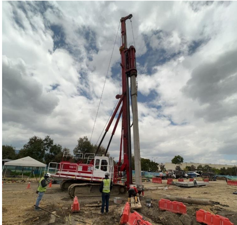
Imagen 9. Hincado de pilotes prefabricados. Fuente: CONSTRUCTORA CONCONCRETO S.A.
