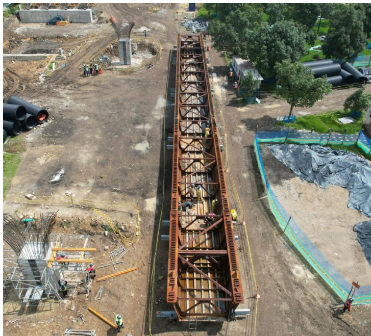
Imagen 14. Foto panorámica construcción de columnas y viga del puente Fuente: CONSTRUCTORA CONCRETO S.A.
