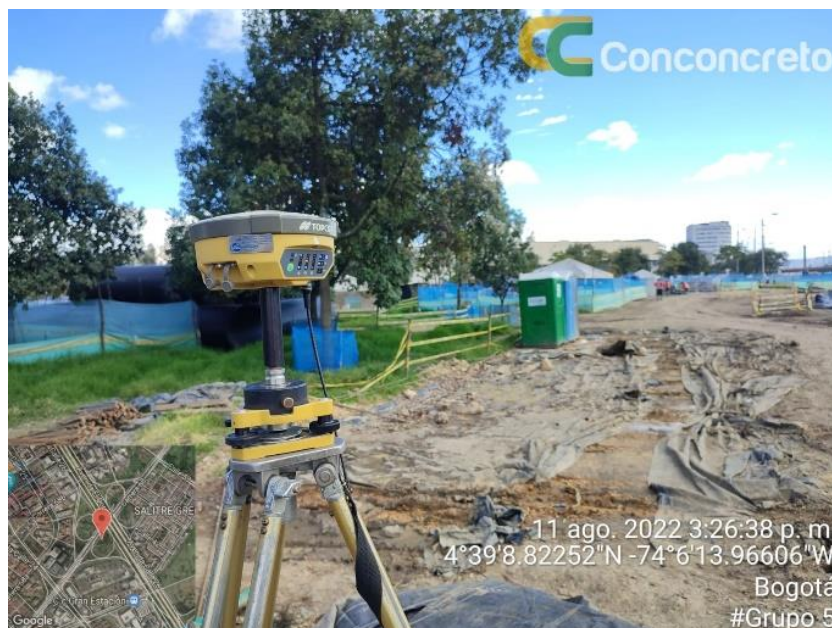
Imagen 7. Equipo topográfico para realizar localización y replante, Fuente: CONSTRUCTORA CONCRETO S.A.
