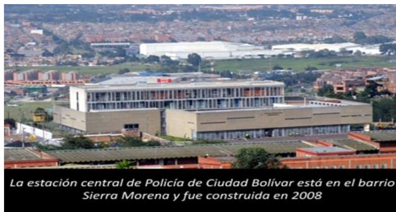
Imagen No 2 Registro fotográfico estructura de la Estación de Policía Ciudad Bolívar
