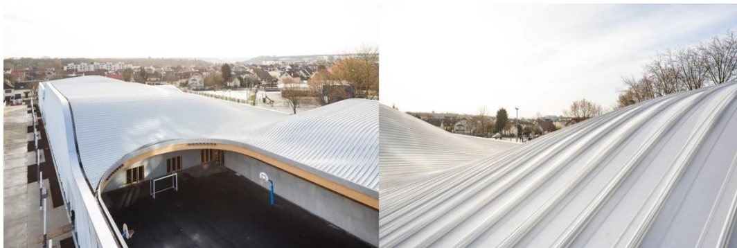
Figura 44. Aplicación laminas BEMO N-6..
